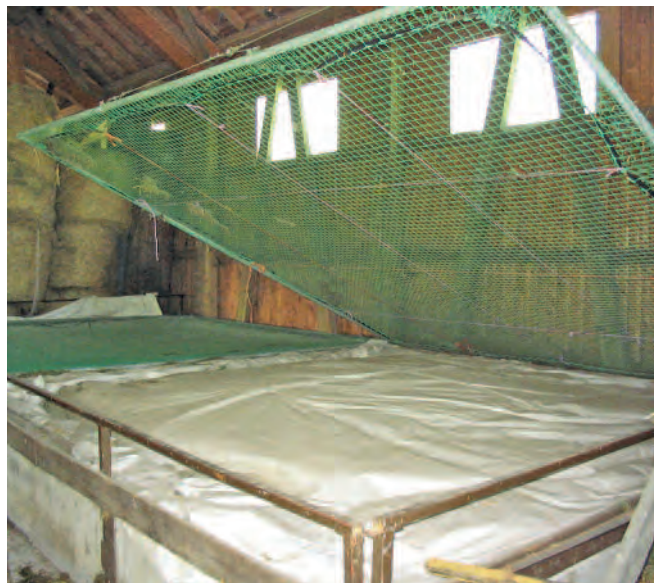
Das Tiefsilo kann mithilfe eines scharnierten Deckels automatisch geöffnet und geschlossen werden.
