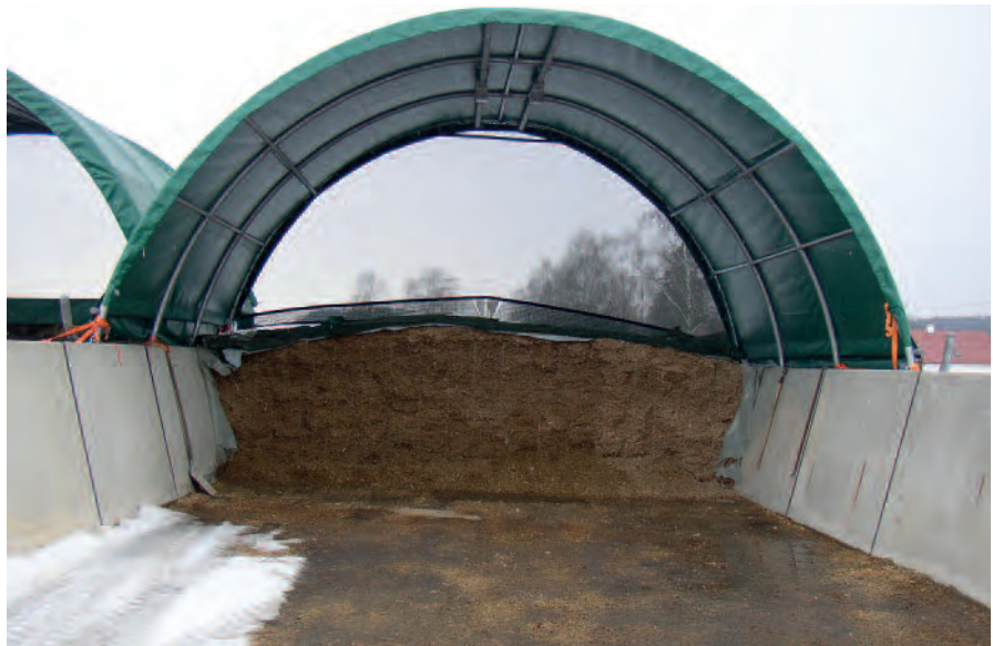
Einen guten Schutz vor Witterungseinflüssen bietet ein Folienrundbogen.
