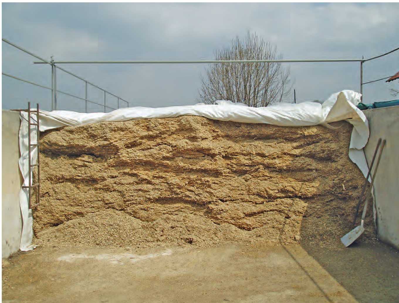
Hier wurde eine Absturzsicherung an der Entnahmekante angebracht.
