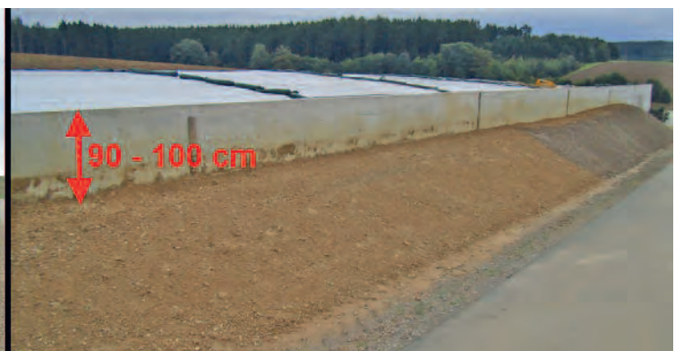
Ohne hohen Kostenaufwand sorgt ein Erdwall an der Außenseite für die nötige Absturz-sicherung.
