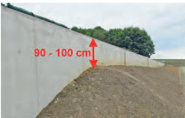
Ohne hohen Kostenaufwand sorgt ein Erdwall an der Außenseite für die nötige Absturz-sicherung.
