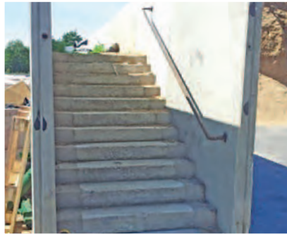
Ein Laufsteg an der Außenseite des Fahr-silos sorgt für die nötige Sicherheit. Auch an den Zugang zum Laufsteg sollte gedacht werden.
