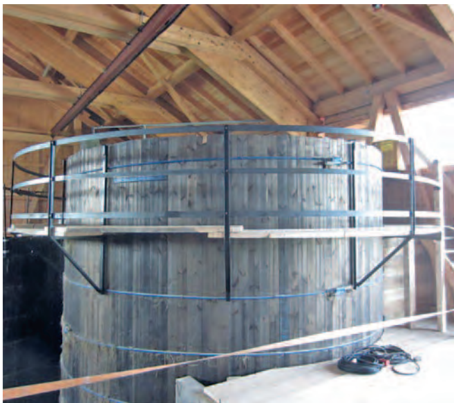
Der Laufsteg rundum das Hochsilo sollte mindestens 1 m tiefer angebracht werden.
