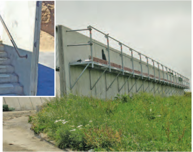
Ein Laufsteg an der Außenseite des Fahr-silos sorgt für die nötige Sicherheit. Auch an den Zugang zum Laufsteg sollte gedacht werden.
