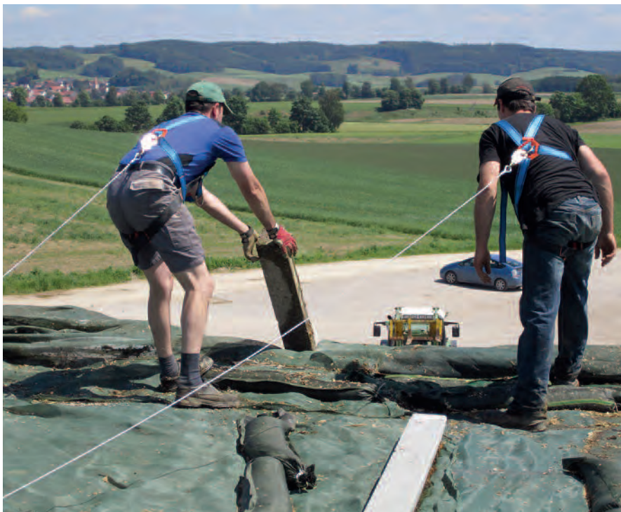
Das Anseilen der Arbeiter kann schlimme Sturzunfälle vermeiden.
