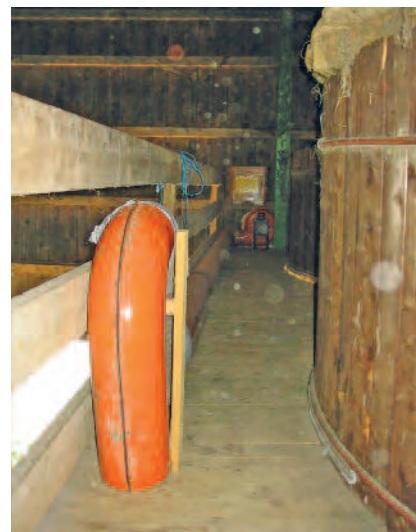
Fest installierte Silobelüftung mit Laufsteg.
